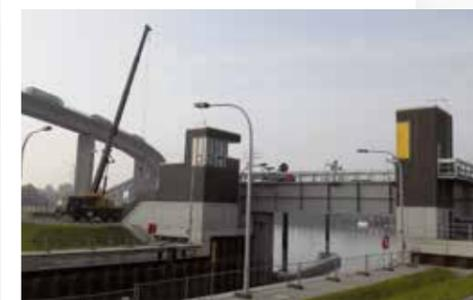
Bei der 2016 in Betrieb genommenen Rugenberger Schleuse lieferten und montierten wir acht über Triebstockritzel angetriebene Oberwagen, welche die über Koppelstangen verbundenen Torflügel öffnen und schließen.
