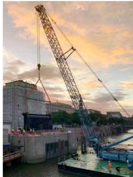
Das Nikolaisperrwerk wurde im Jahre 1986 mit zwei redundanten, hintereinander liegenden Stahlklapptoren gebaut. Sie werden mit einseitig montierten hydraulischen Antrieben geschlossen und geöffnet. Die Hydraulikzylinder befinden sich im Bauwerk unterhalb der Sperrwerksoberfläche. In der Grundinstandsetzung war geplant, die alte Antriebstechnik durch eine dem neuesten Stand der Technik entsprechenden Anlage zu
