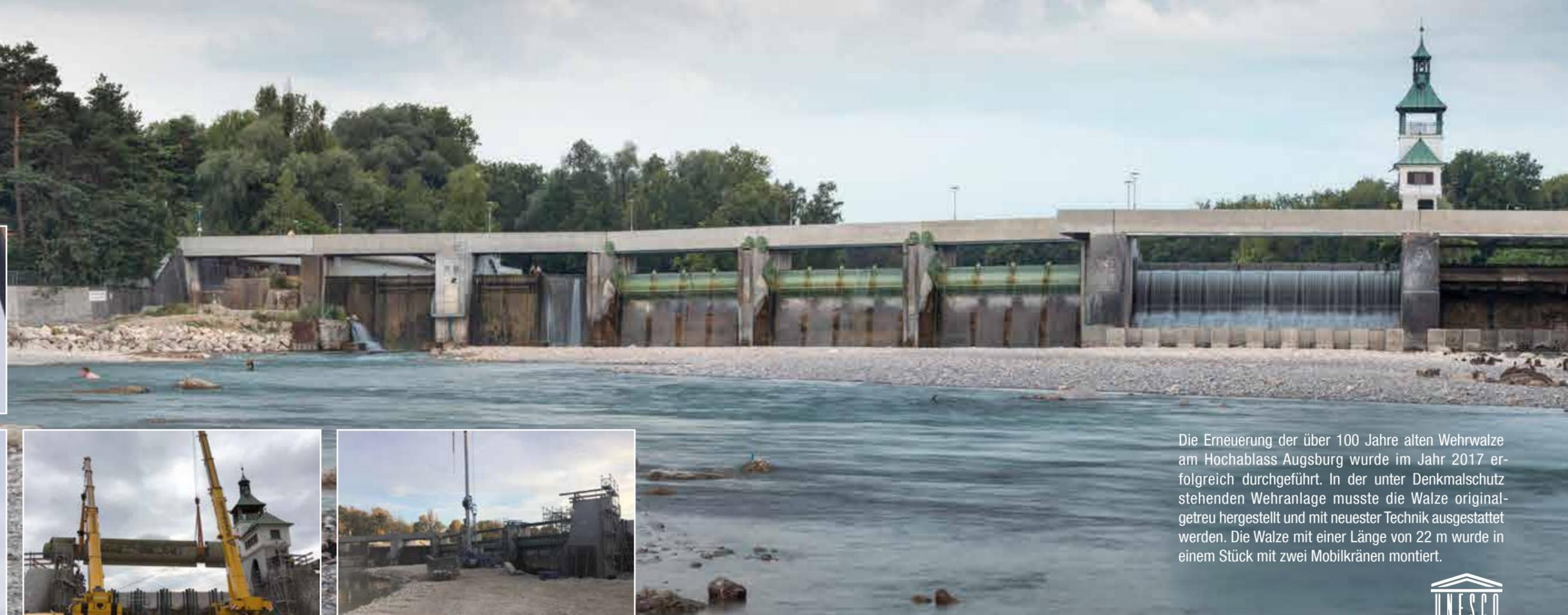
Die Erneuerung der über 100 Jahre alten Wehrwalze am Hochablass Augsburg wurde im Jahr 2017 erfolgreich durchgeführt. In der unter Denkmalschutz stehenden Wehranlage musste die Walze originalgetreu hergestellt und mit neuester Technik ausgestattet werden. Die Walze mit einer Länge von 22 m wurde in einem Stück mit zwei Mobilkränen montiert.
